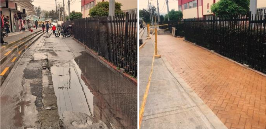
Intervención carrera 24 entre carrera 22 y 20
